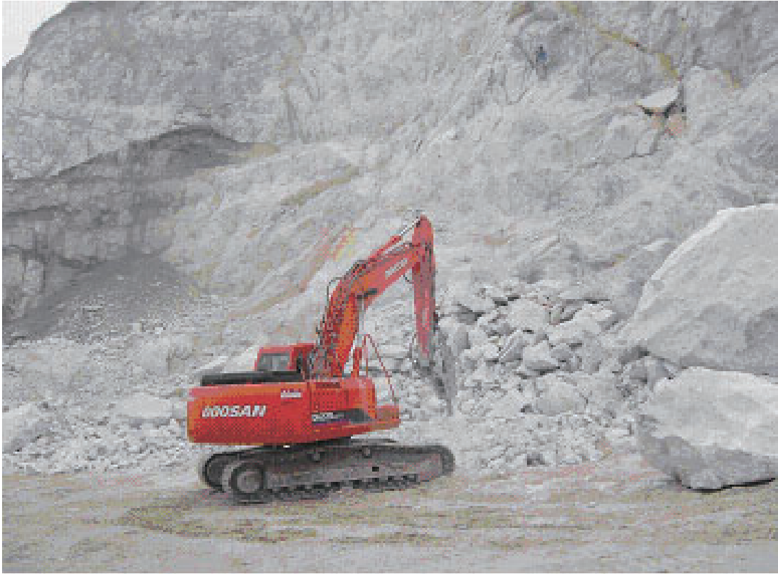
圖7.3_1 梨樹溝項目 礦內碎石作業
