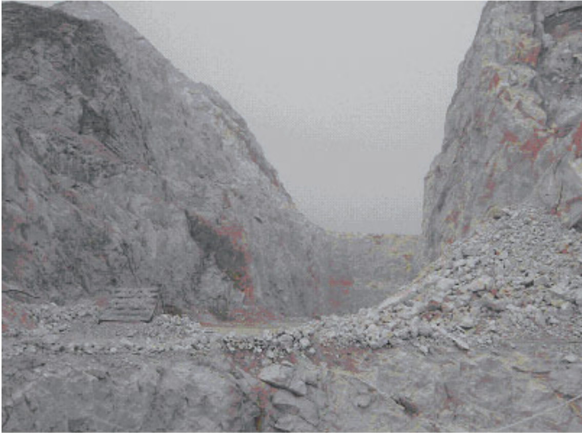
圖7.2_2 梨樹溝項目 過陡的基坑邊坡
